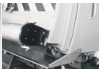
Conduite de l'air
